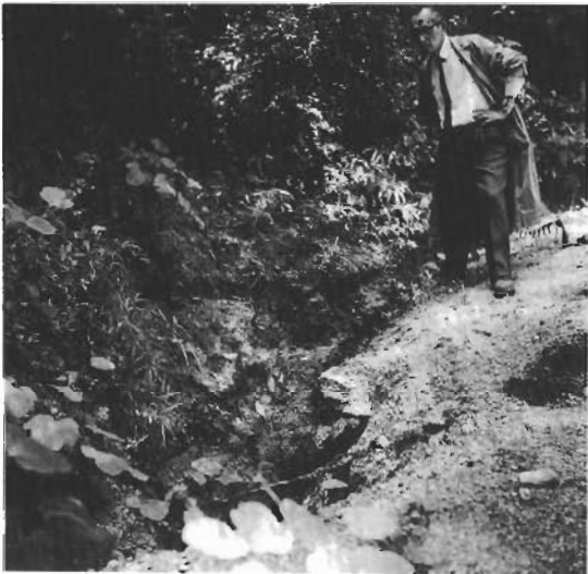
水害で崩壊した道路を視察中のありし日の辰野先生
