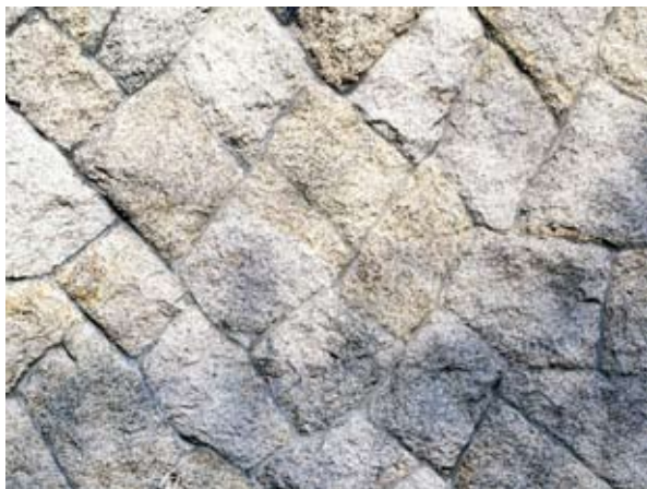
室浜砲台跡、弾薬庫外壁（廿日市市宮島町、2002 年 8 月、向井・坪田撮影）
