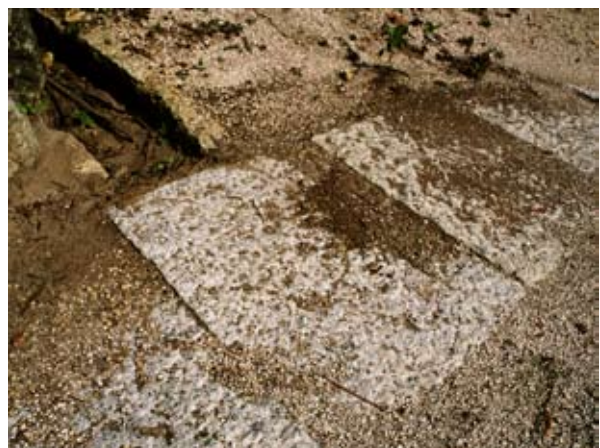
室浜砲台跡、石の蓋で覆われた排水路（廿日市市宮島町、2002 年 8 月、向井・坪田撮影）
